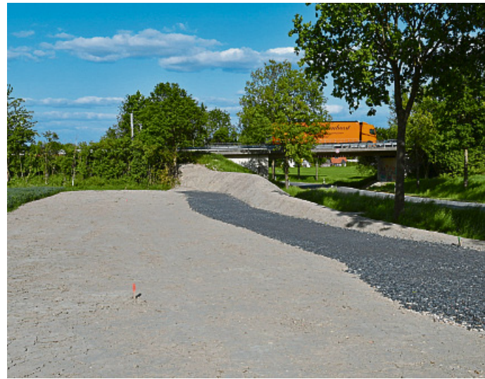
Das neu gebaute Starkregnerückhaltebecken an der Eggeroder Straße soll vor Überflutungen schützen.
